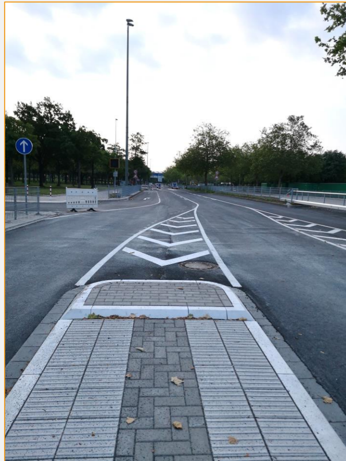
Verkehrinsel mit Flachbordsteinen und Bodenindikatoren
