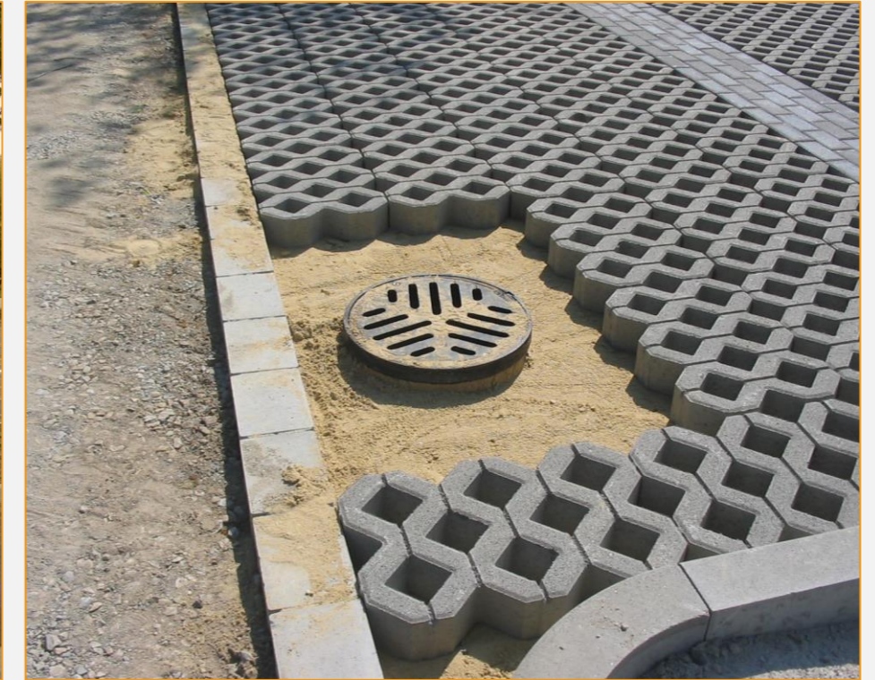
Einbau Drainagekontrollschacht
