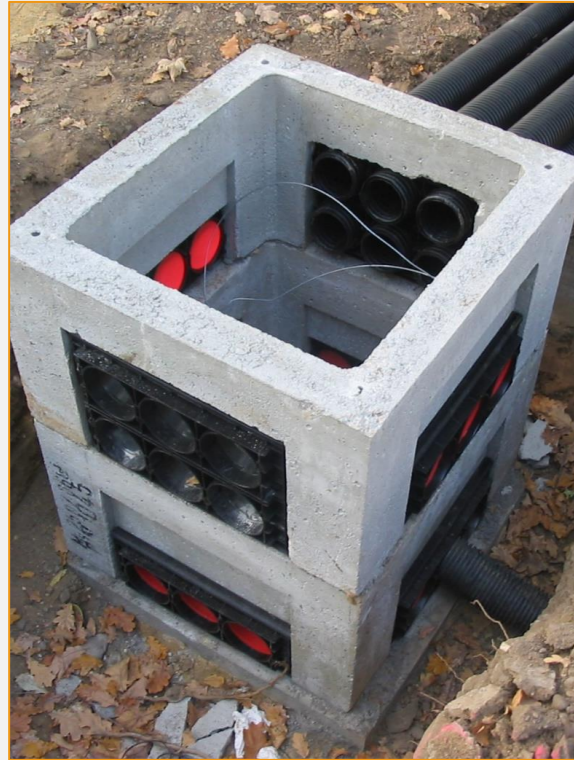
Einbau Kabelschacht
