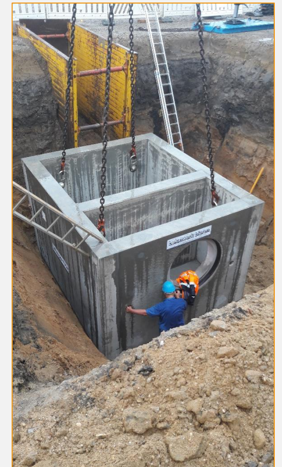
Einbau Drosselbauwerk
